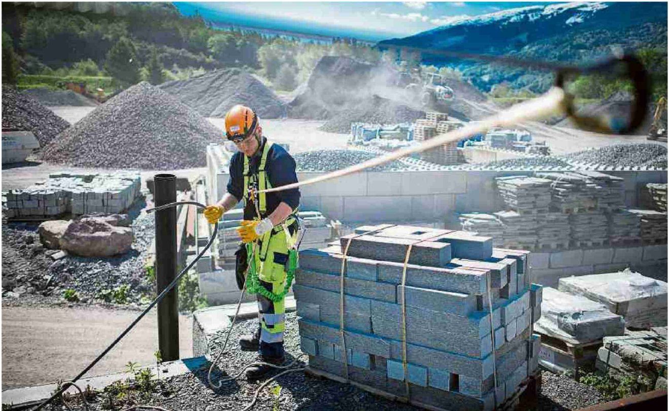
Tim Wernli sichert sich für seinen Einsatz in vier Meter Höhe. Im Qualifikationsverfahren muss er eine Entwässerungsleitung hydrodynamisch reinigen.
