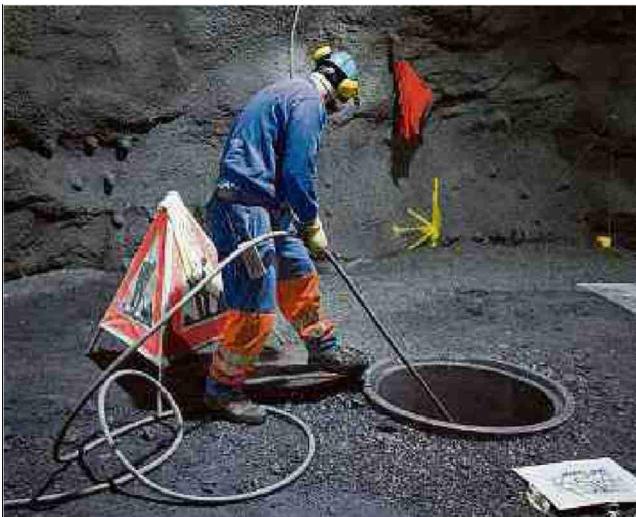
Mit einer Kamera wird der Kanal nach Hindernissen abgesucht.
