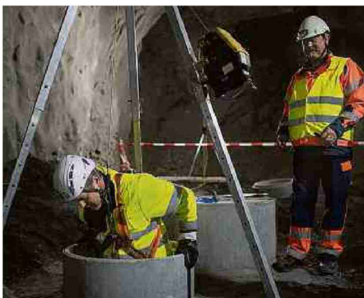
Für eine Wasserprobe steigen die Lernenden in einen Schacht.
