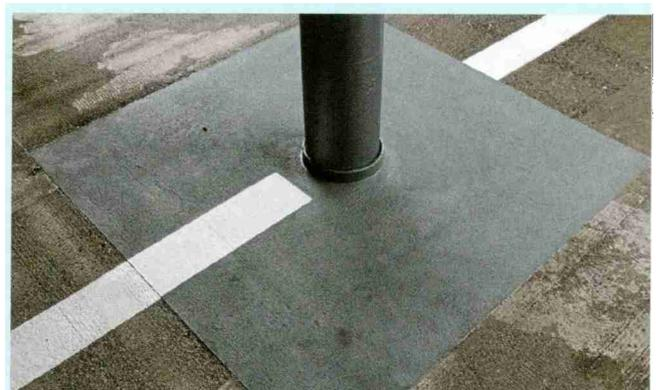
Saniertes Metallstützenfuss mit Abdichtung.
